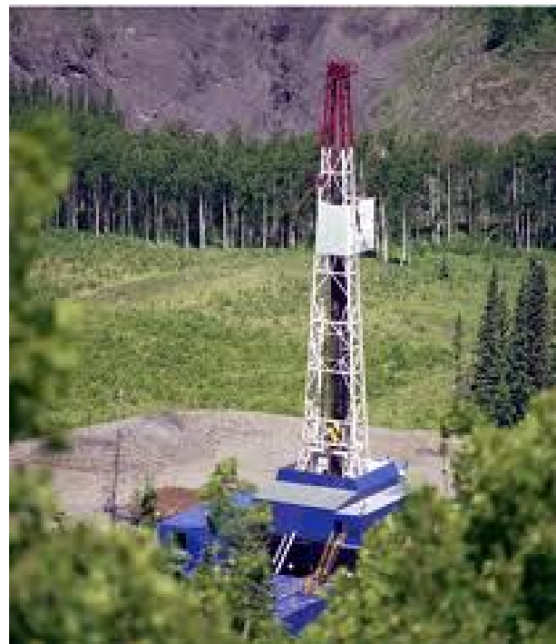
Tour de forage conventionnelle pour extraire du gaz naturel
